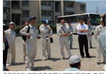
5月23日 道路拡張の現地視察(甲斐市・滝坂)
