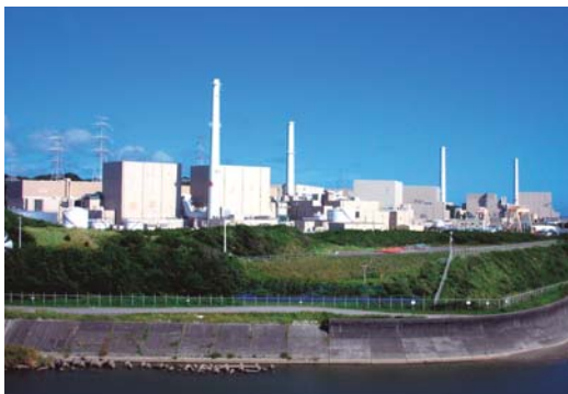
浜岡原発外観(特別に施設内を視察する事ができました。)
